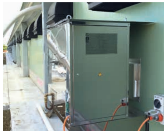
instalación en el exterior
