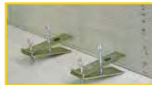
1º Posicionar niveladores.
