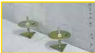
1º Posicionar niveladores.
